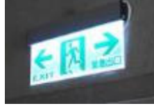
緊急逃生指示燈 汰換LED型燈具
